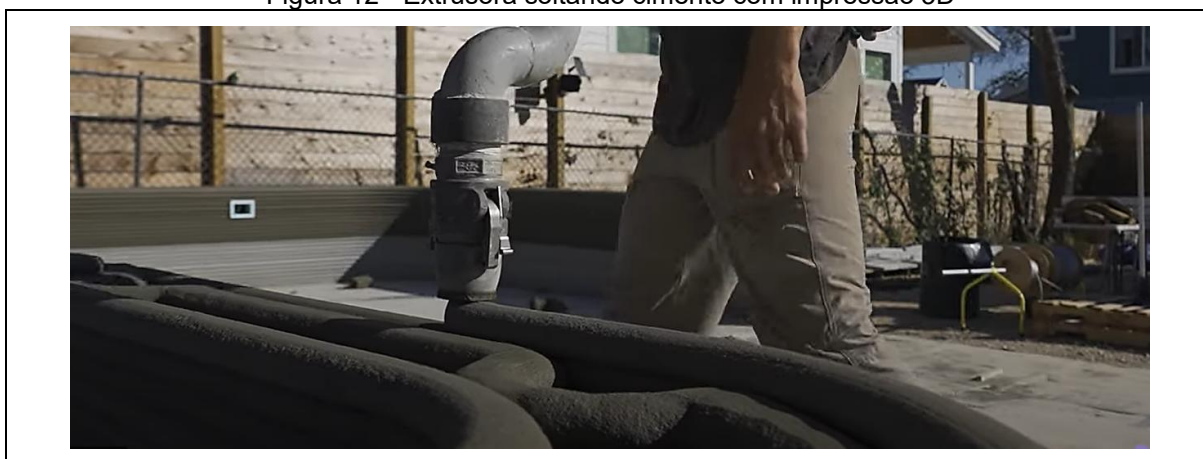
Figura 12 - Extrusora soltando cimento com impressão 3D
