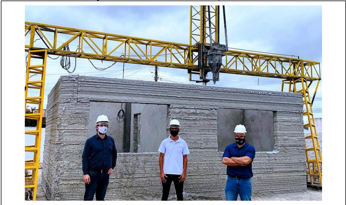
Figura 11 - Casas construídas com impressão 3D
