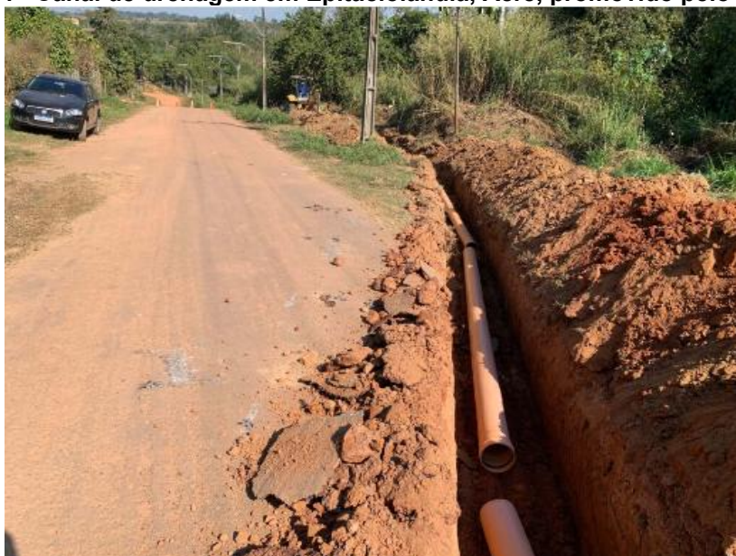
Figura 44 - Canal de drenagem em Eptaciolândia, Acre, promovido pelo Saneacre
